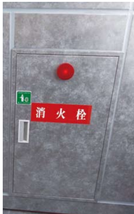
施工例(2号消火栓)
