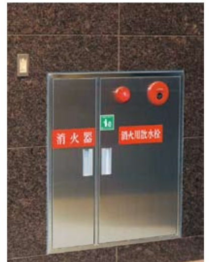
施工例 (SUS製ヘアライン仕上げ)
