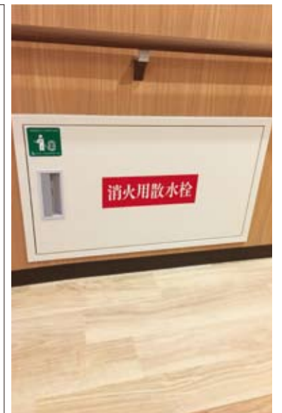
施工例 (補助散水栓)
